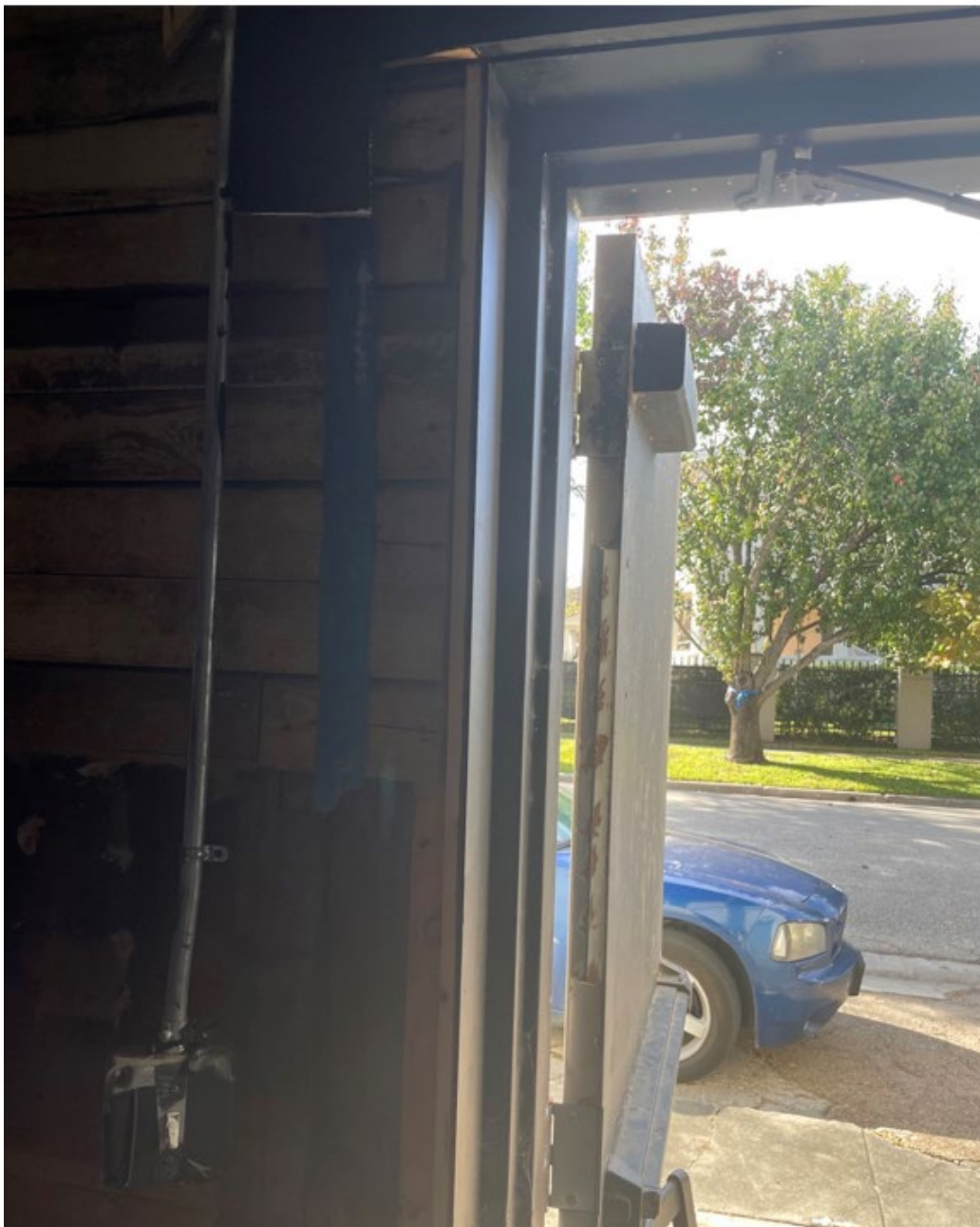
NEW DOOR FRAMING
